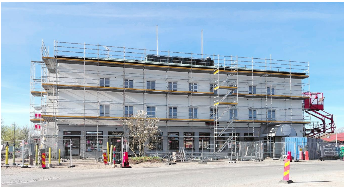
På bild: Pågående renovering av Stadshotellet, 2025. Bilden visar byggnaden innan ommålning.
